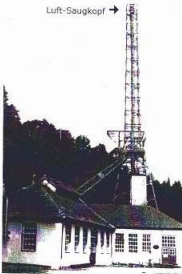
Der Hydrokompressorenturm am Kneesebeck-Schacht - Ansicht von Osten mit Kompressorenhalle, Schachthalle und Fördergerüst.
