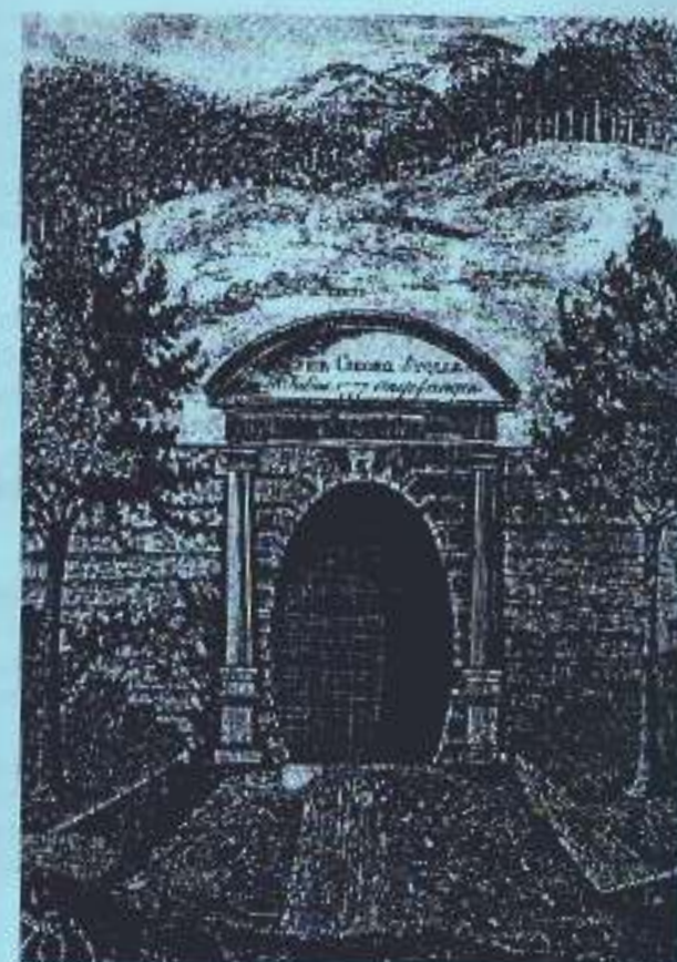
Das Mundloch des Tiefen Georg-Stollens in Bad Grund (nach einer zeitgenössischen Darstellung, 19. Jhd.).
