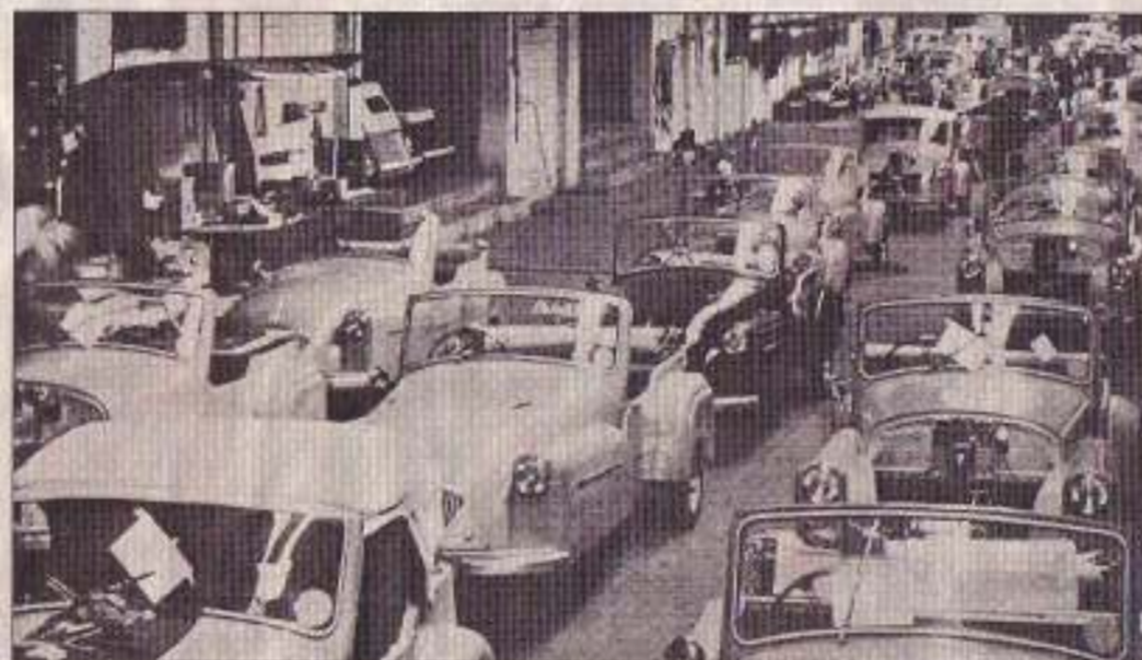
Die Fabrikation von Autos war lange Zeit eine Arbeit, bei der die Monteure viel technisches Wissen mitbringen mußten und die Autos bei der Produktion jeweils von Beginn der Arbeiten bis zur Auslieferung begleiteten. Die änderte sich mit Einführung der Fließbänder in den Automobilfabriken.
